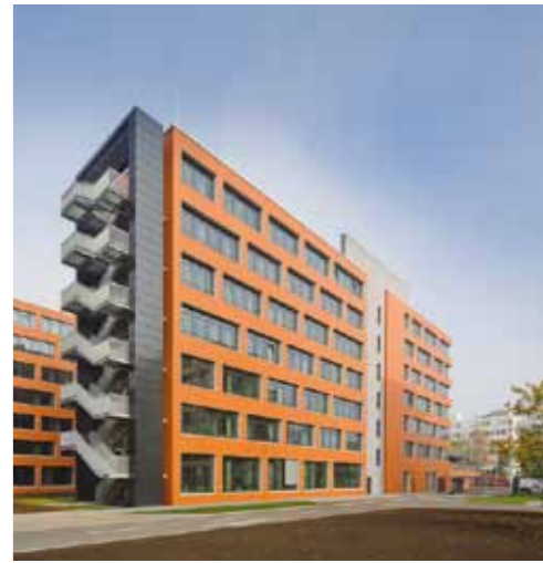
Neubau Evonik Verwaltungsgebäude im Industriepark Wolfgang in Hanau
